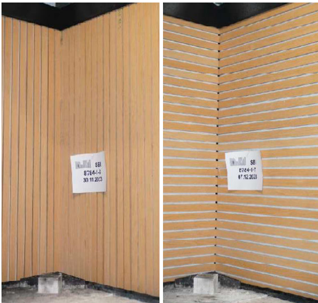
Abbildung 1: Probemontage im SBI - Vertikale und horizontale Ausrichtung der Lamellen.
